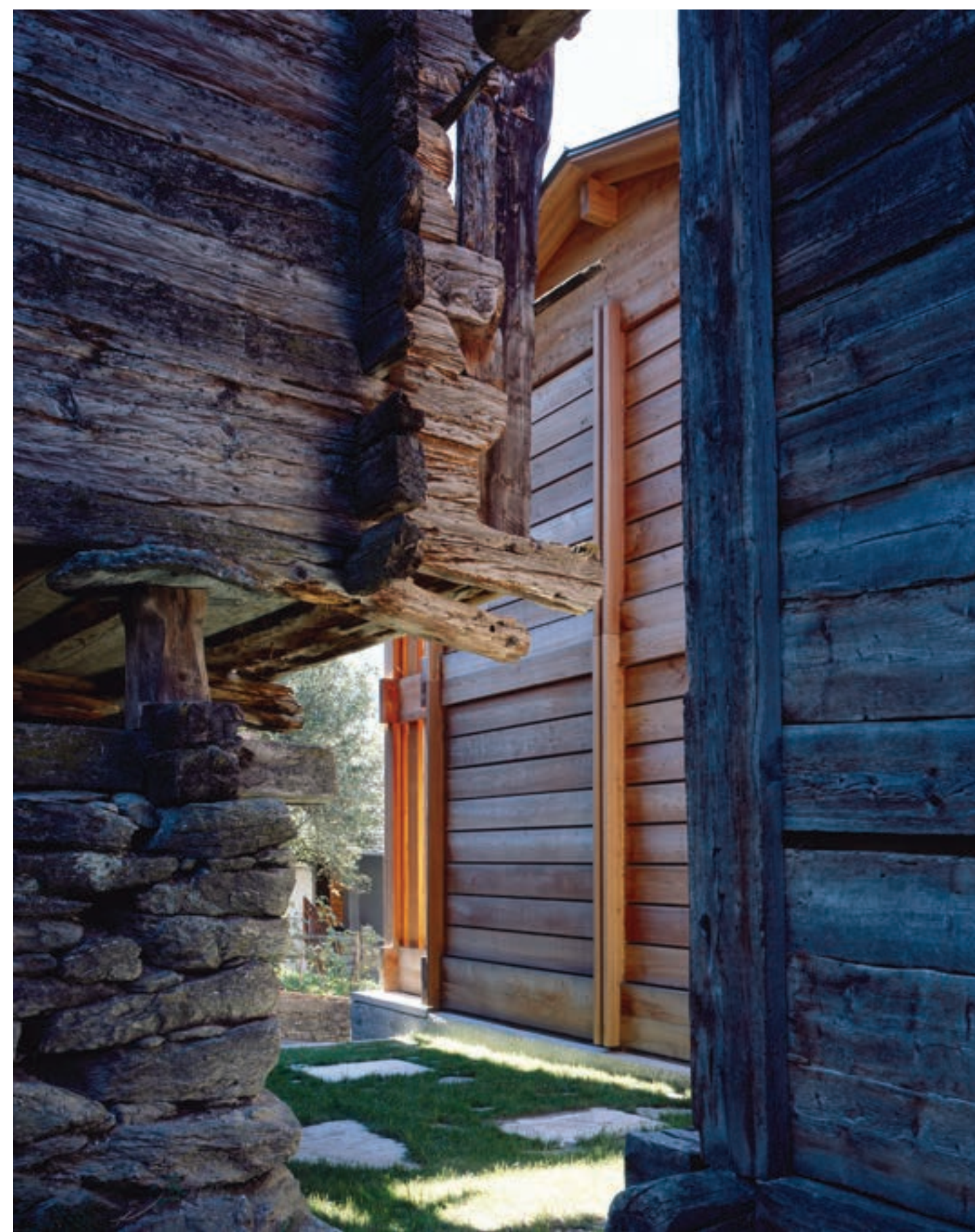
Der neue Anbau zwischen dem Nachbarhaus und dem umgebauten alten Haus
